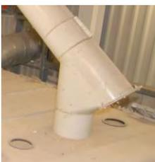
O tamanho e a posição das bocas de descarga podem ser consultados na folha de dimensões. Durante a montagem das bocas de descarga deve ser assegurado que todas as vedações permanecem acessíveis para possibilitar reajustes posteriores.
